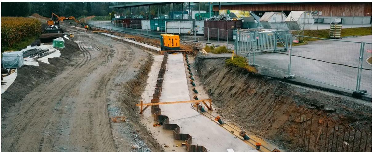
Installierte Pfähle werden in das Hochwasserschutz-Betonfundament eingebunden
